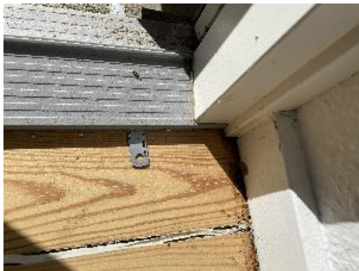
Terrassedør står direkte på indvendig gulvbelægning
