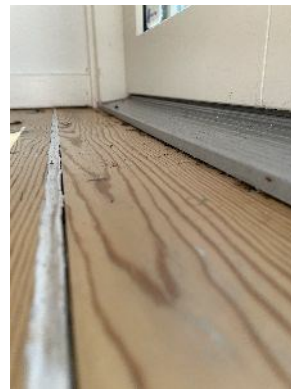
Terrassedør står direkte på indvendig gulvbelægning
