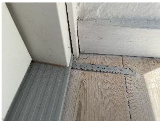
Terrassedør står direkte på indvendig gulvbelægning
