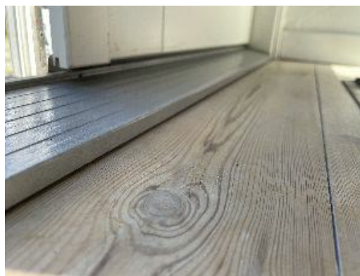
Terrassedør står direkte på indvendig gulvbelægning
